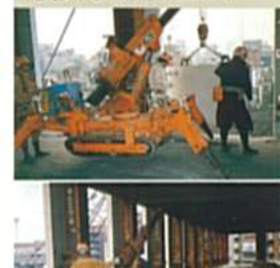
TC-204 PC板張り付け(重量800kg)
