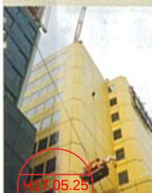
TC-304 屋上へ吊り上げ
