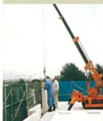
TC-204 ALC設置工事
