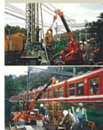
TC-204 PC板張り付け(重量800kg)
