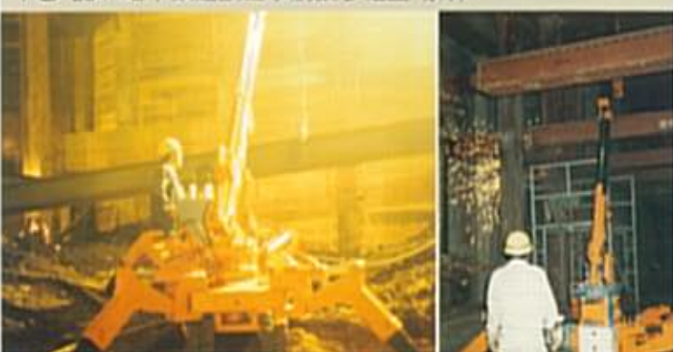
TC-204 地下鉄建設工事胴張り組立・解体
