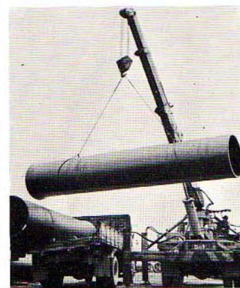
■ 鋼管吊上作業
