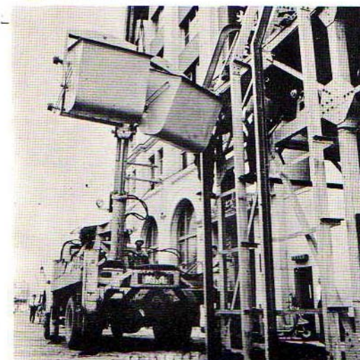
■ 地下鉄工事現場
